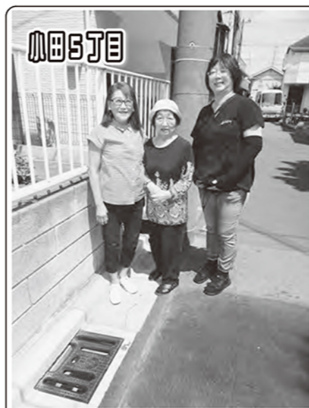
水が流れなかったゴミ集積所に集水口を設置
